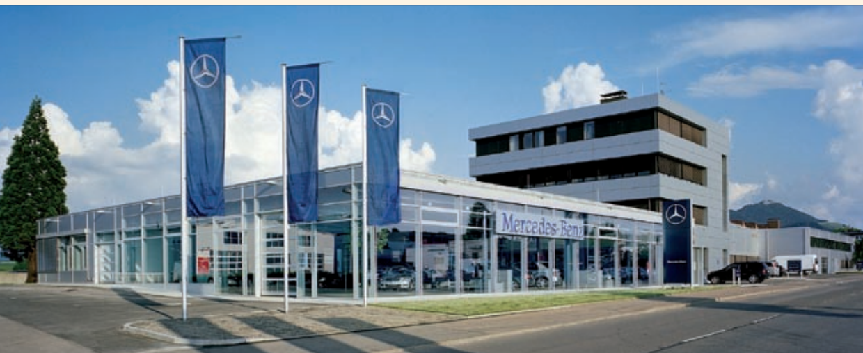
Komplett umgebaut hat das Autohaus Russ seinen Dettinger Betrieb. Die Seniorgesellschaftler haben die Baumaßnahmen begleitet.
